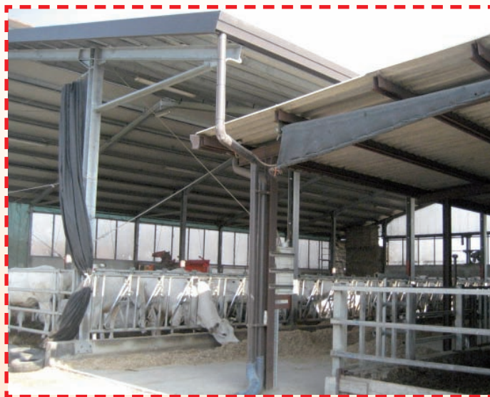
Az. Cappello Mattia, Panoramica delle strutture
